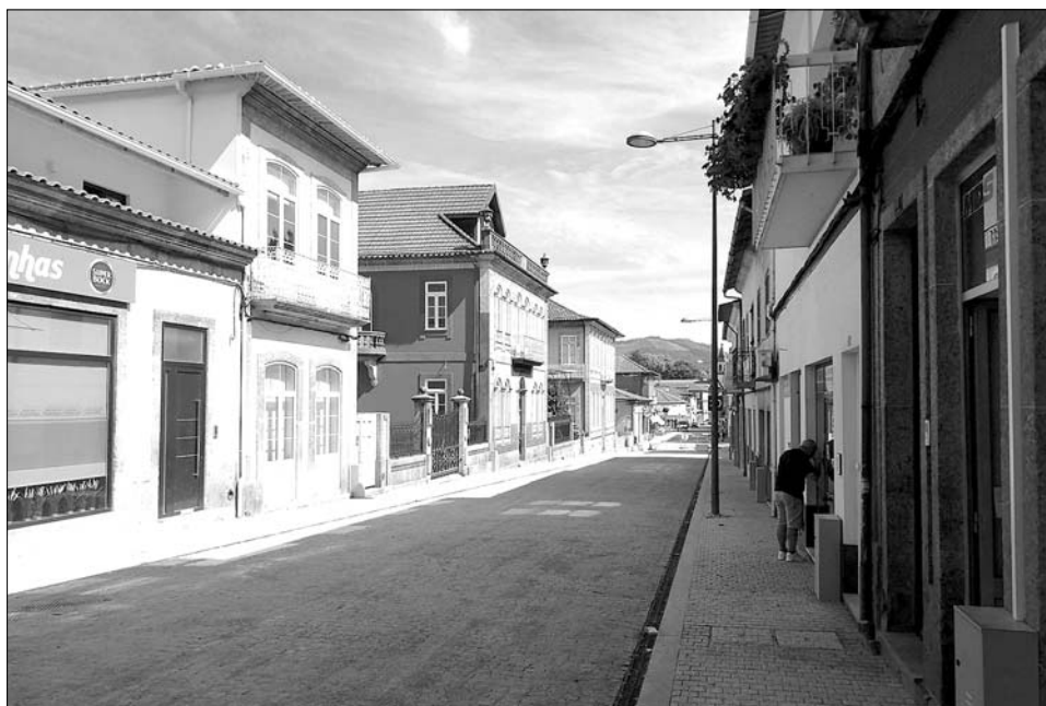
Aspeto da Rua Dr. Abílio Torres
