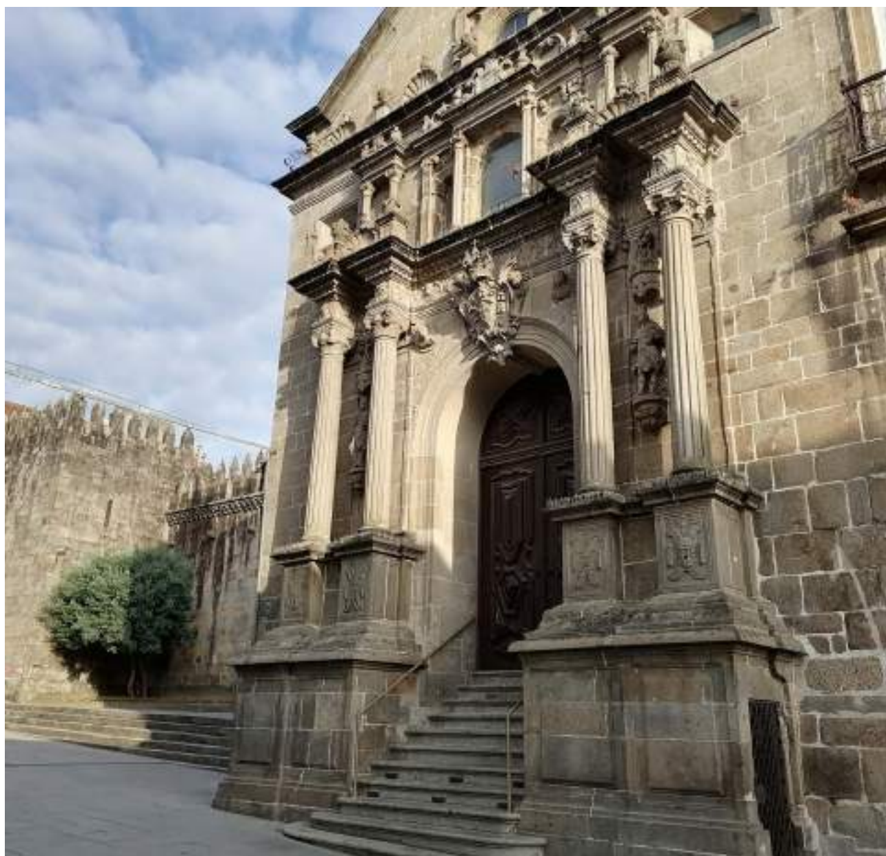
Exterior da Igreja da Misericórdia
