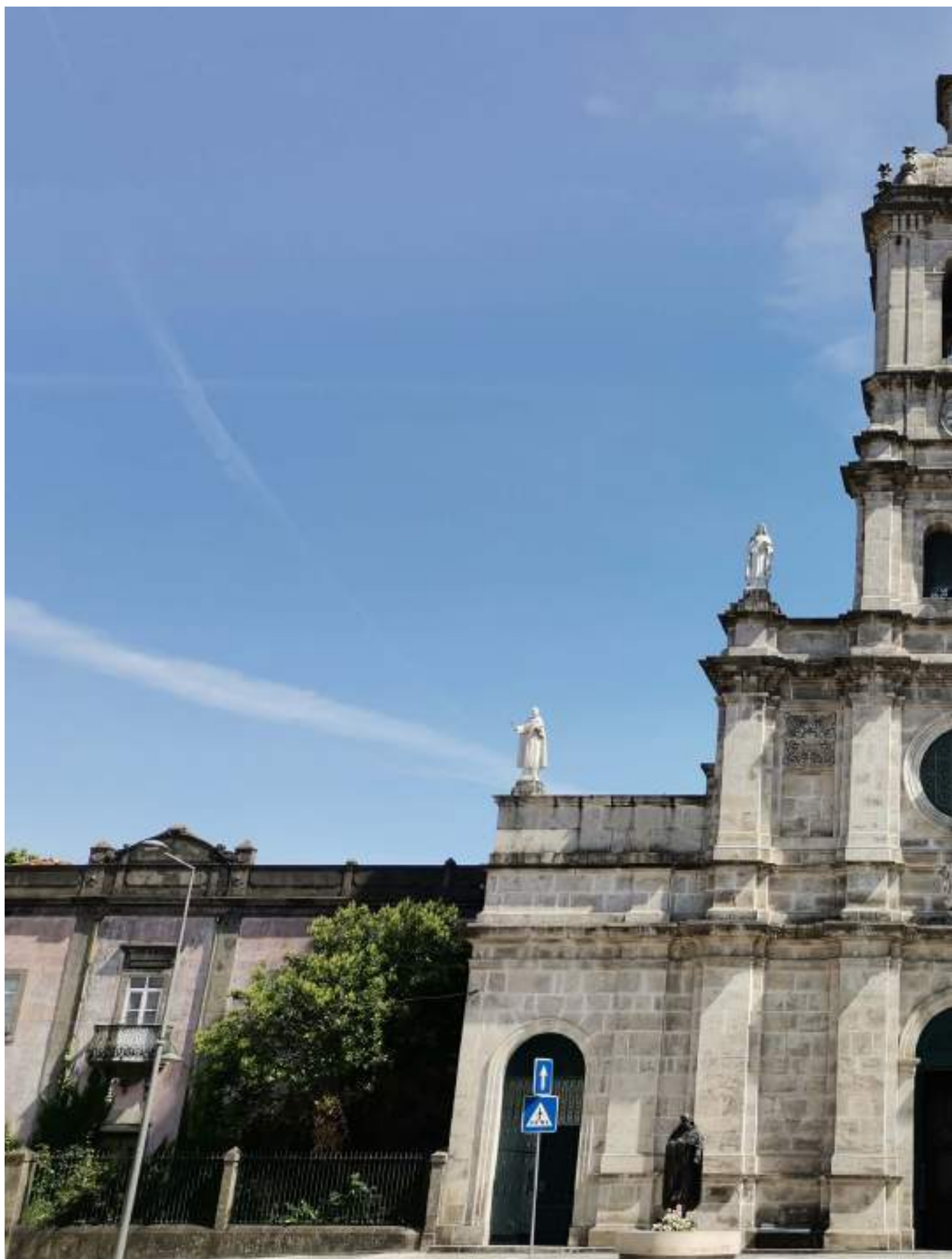
Exterior da Igreja do Carmo
